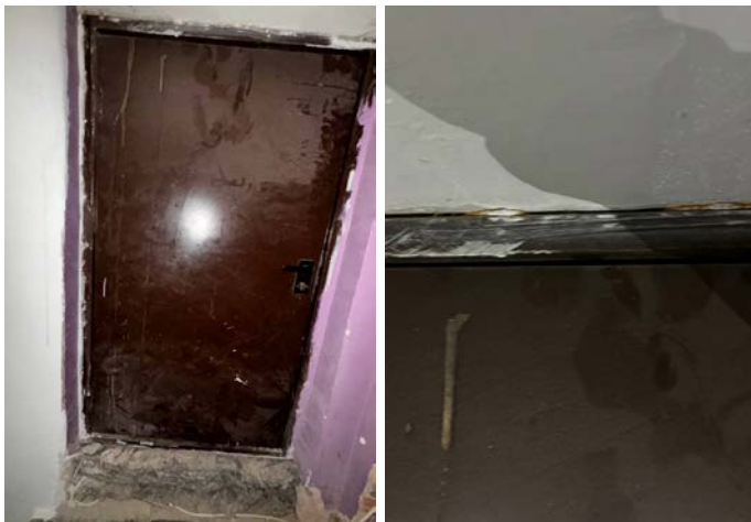
Pilt 6. Keerdtrapikojast kolmandale korrusele viiv uks
