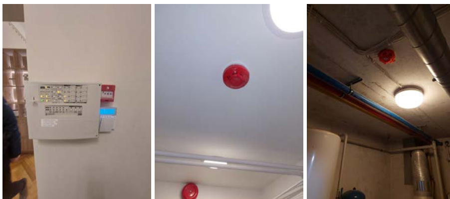
Pilt 10. ATS keskseade ja fotod paarist katikuga kaetud andurist
